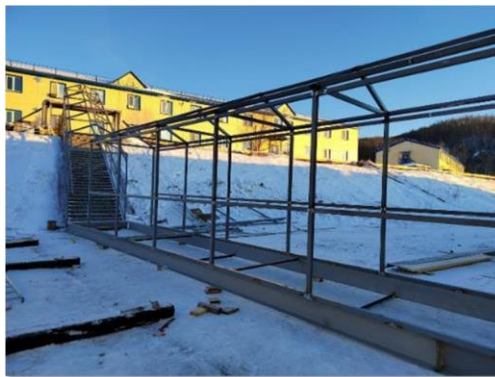
Установка крытых переходов для предотвращения поскользываний
